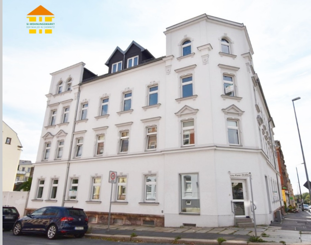
Frankenberger Straße 206 in 09131 Chemnitz
