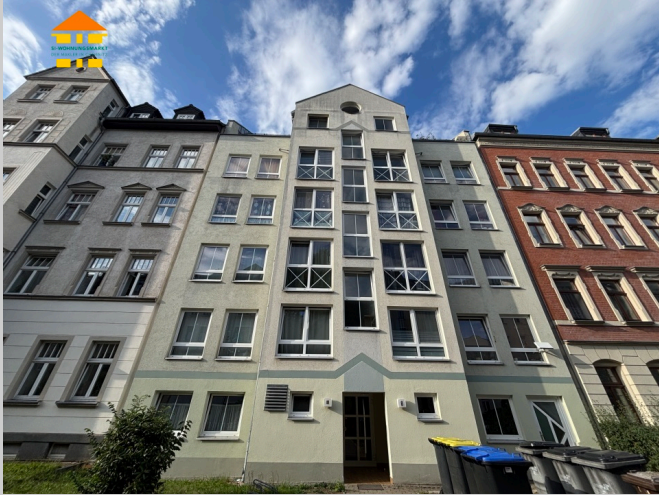
Rudolf-Marek-Straße 8 in 09112 Chemnitz
