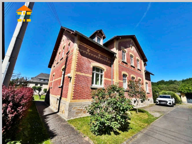
Gottfried-Keller-Straße 46 in 09113 Chemnitz
