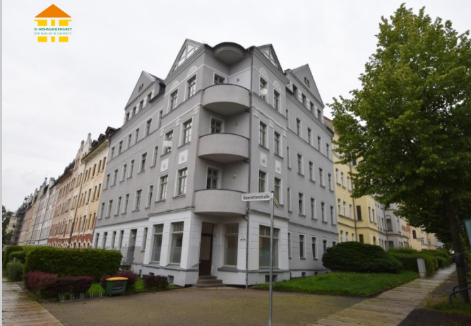
Henriettenstraße 77 in 09112 Chemnitz
