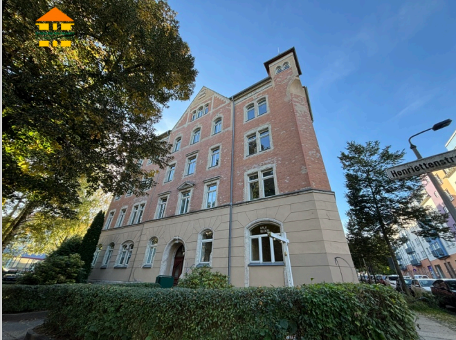
Henriettenstraße 23 in 09112 Chemnitz
