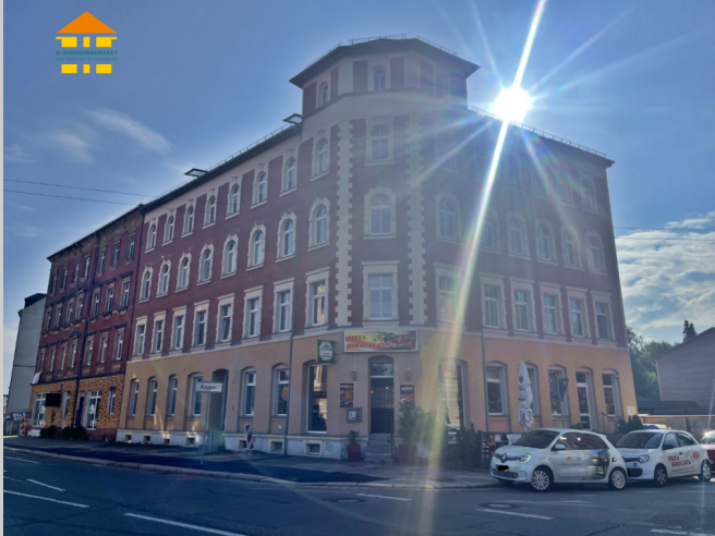
Zwickauer Straße 205 in 09116 Chemnitz
