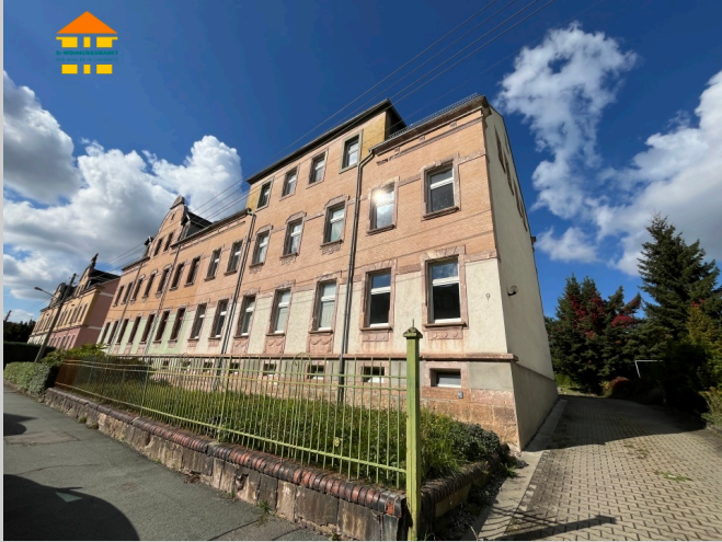
Klopstockstraße 9 in 09131 Chemnitz
