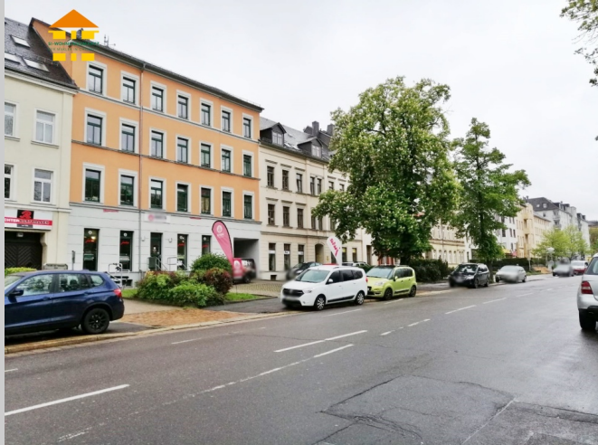
Straße der Nationen 112 in 09111 Chemnitz
