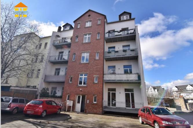
Reichenhainer Straße 7 in 09126 Chemnitz
