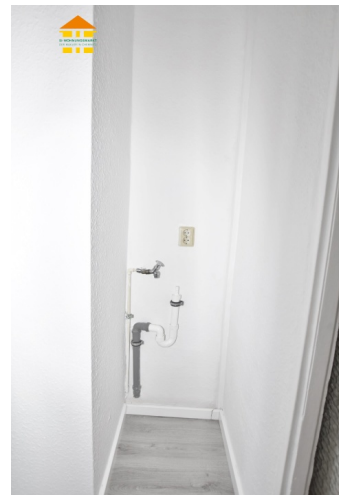
Waschmaschinenanschluss
