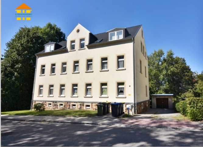
Friedrichstraße 5 in 09232 Hartmannsdorf
