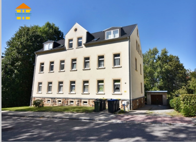
Friedrichstraße 5 in 09232 Hartmannsdorf
