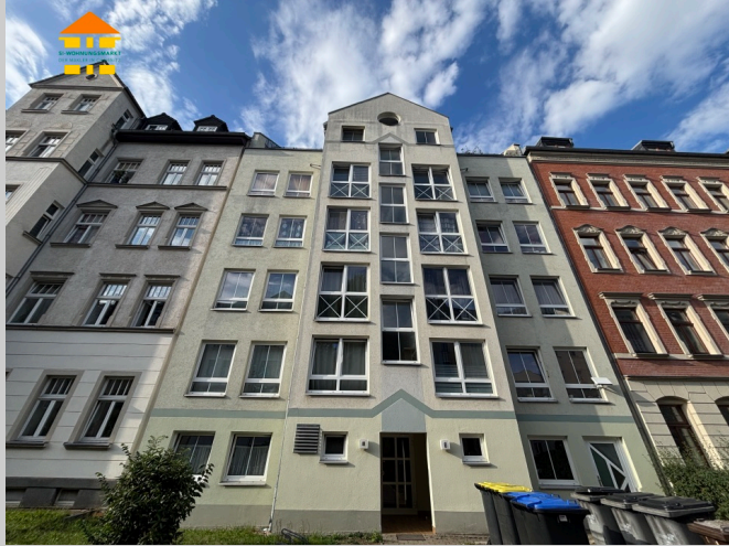
Rudolf-Marek-Straße 8 in 09112 Chemnitz
