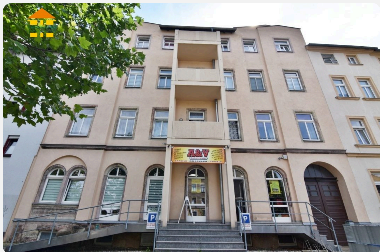
📍 Straße der Nationen 100 in 09111 Chemnitz
